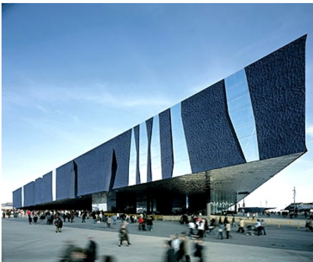
Edificio Fórum en Barcelona
